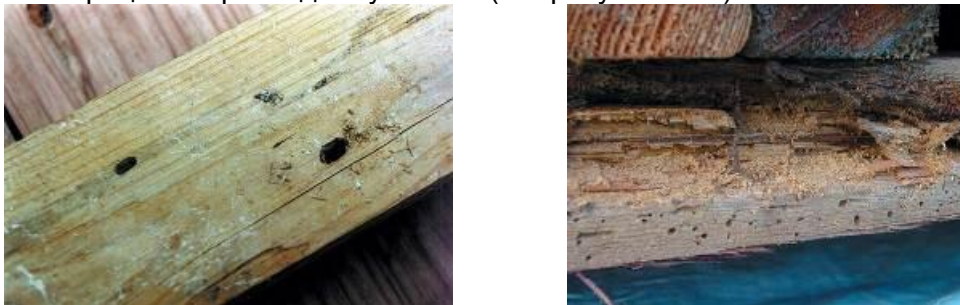
Рисунок 6.13. Древесная мука как результат деятельности насекомых-древоточцев
