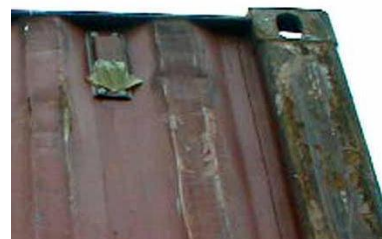
Рисунок 5.20. Заклеенное вентиляционное отверстие
