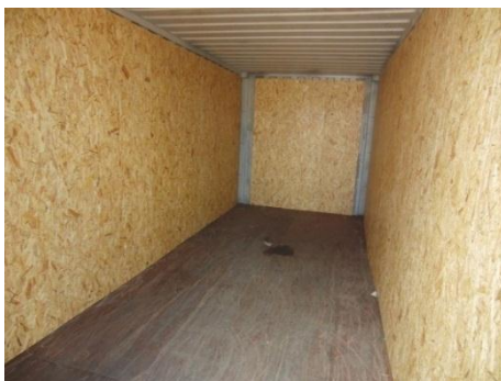
Рисунок 7.53. Облицовка 40-футового контейнера древесностружечными плитами
